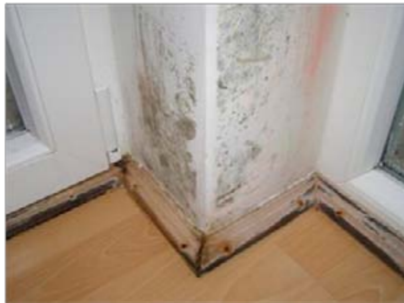
2. ábra: Hőhid okozta penészesedés (Forrás: http://szelloztetes.hu/index.php?m_id=2&id=103 )
